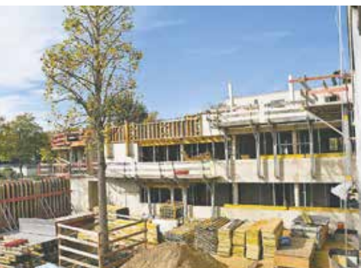
Umbauarbeiten am Rathaus in Kaster
