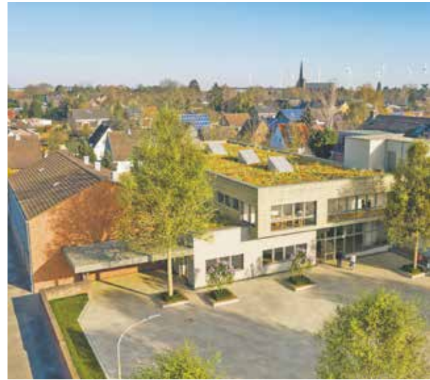
Vogelperspektive Anbau Geschwister-Stern-Grundschule. © Architekt Thomas Schmitz / Visualisierung Holtgrewe
