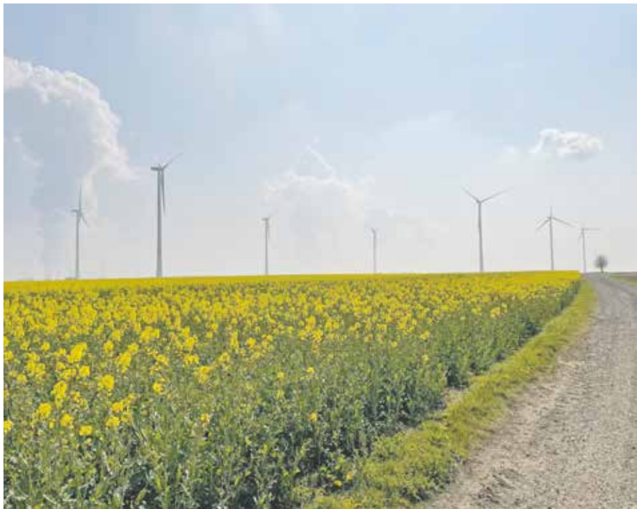
Der Überschussstrom des Windparks Königshovener Höhe soll künftig zur Erzeugung von „grünem“ Wasserstoff verwendet werden.
