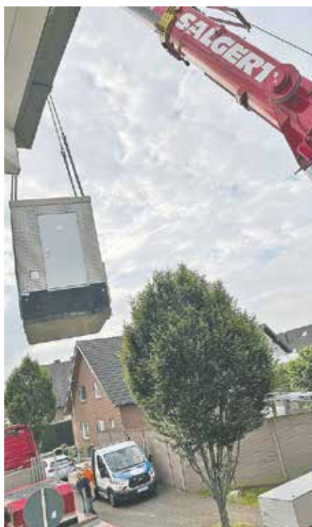
Das Verteilerhaus wird mit schwerem Gerät an seinen Platz gehoben.
