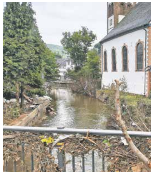
Schäden in Gemünd. © CDU Bedburg
