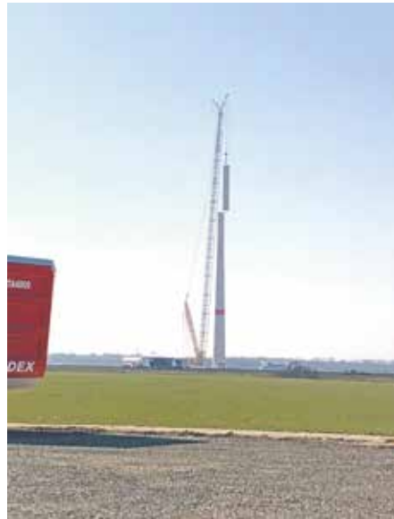
Das Rohr wird aufgesetzt.
