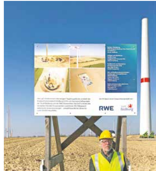
In der Mitte die Informationstafel, links erkennbar der fertige Turm (noch ohne Gondel und Rotorblätter), rechts der halb fertige Turm der WEA 3.
