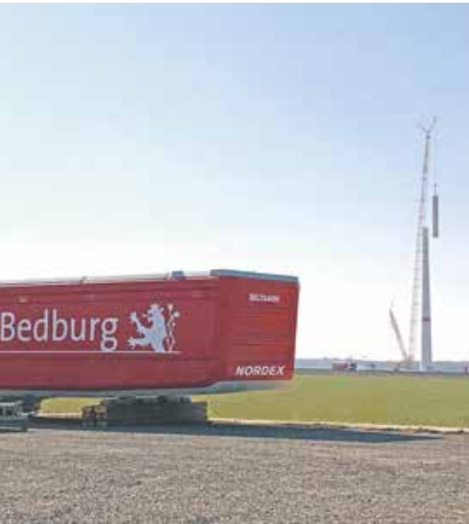
Im Vordergrund die Gondel mit Bedburger Wappen für die Turmspitze, im Hintergrund wird gerade das letzte Rohr für die WEA 1 hochgezogen.
