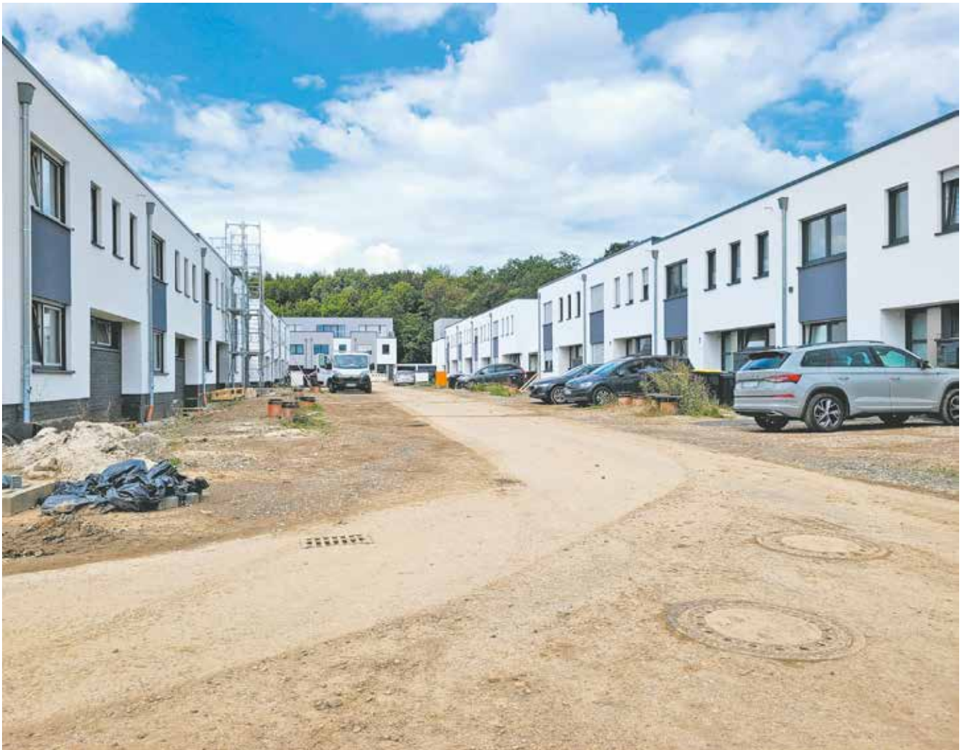
Im westlichen Teil der Ressourcenschutzsiedlung ist der Straßenendausbau gestartet.
