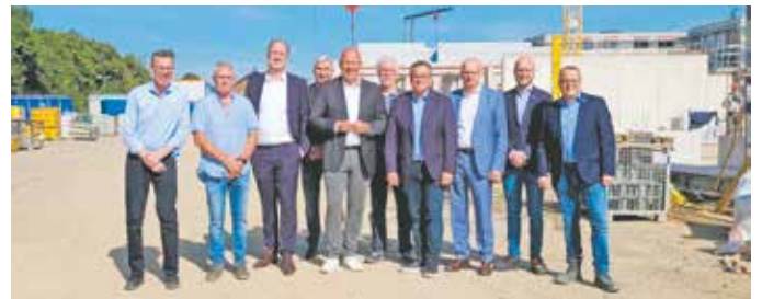
Bürgermeister Sascha Solbach freut sich gemeinsam mit den Gästen über den Neustart der Arbeiten im vorderen Teil des Sonnenfelds.
