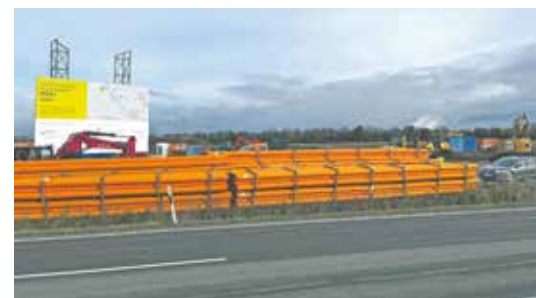
Am interkommunalen Gewerbegebiet „BEB61“ finden derzeit die Erschließungsarbeiten statt.
