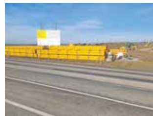
Aktuell finden die Erschließungsarbeiten für das Gewerbegebiet „BEB61“ statt.
