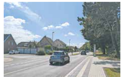
Im Bereich der Albert-Schweitzer-Straße in Kaster wird die Fahrbahn saniert.
