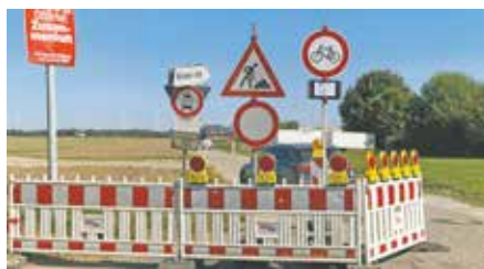
Die Baustelle zur Sanierung der Straße an den Belmener Höfen wird eingerichtet.
