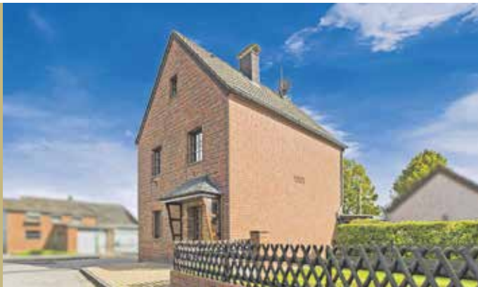
Freistehendes Einfamilienhaus mit Wintergarten in Titz
